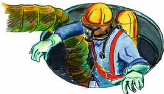
Fig. 8: dans les puits, les fosses et les canalisations qu'on ne peut ventiler suffisamment, il faut absolument porter une protection respiratoire isolante.
