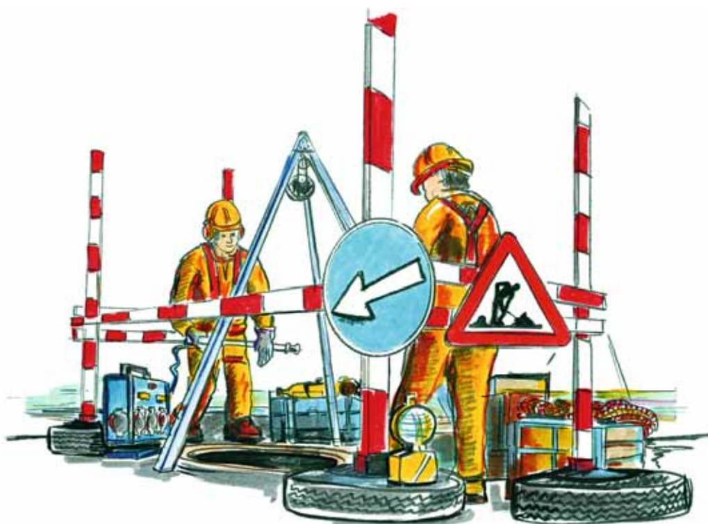
Fig. 4: délimitation et signalisation du secteur de travail.
