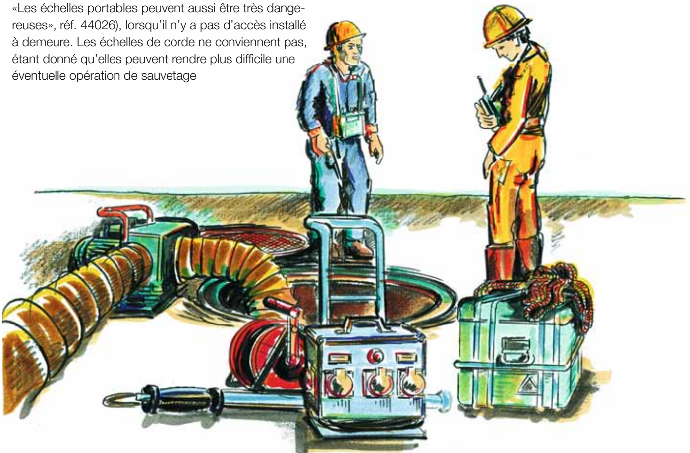
Fig. 2: matériel de prévention dont l'équipe de travail doit disposer: ventilateur, appareil de mesure, matériel électrique, corde de sauvetage.
