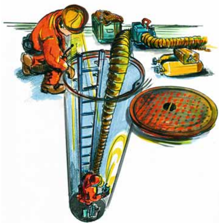
Fig. 9: les personnes travaillant dans les puits, les fosses et les canalisations doivent être surveillées de l'extérieur. La personne chargée de la surveillance doit immédiatement organiser les mesures de secours en cas de situation critique ou d'accident.
