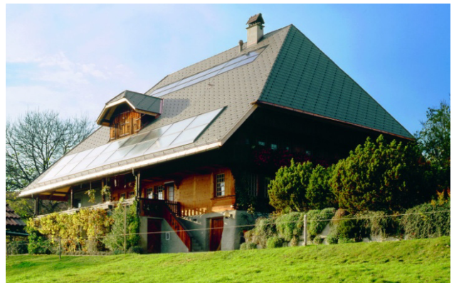
4 Une installation solaire nécessite des mesures planifiées pour la sécurité d'accès et la protection contre les chutes.
