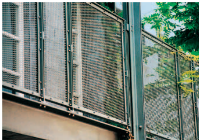
Garde-corps en tôle déployée encadrée et fixée sur une construction primaire, pas d'ouvertures supérieures à 12 cm de diamètre
