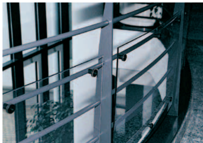
Verre de sécurité monté à l'intérieur sur une hauteur de 75 cm: le verre rend l'escalade plus difficile
