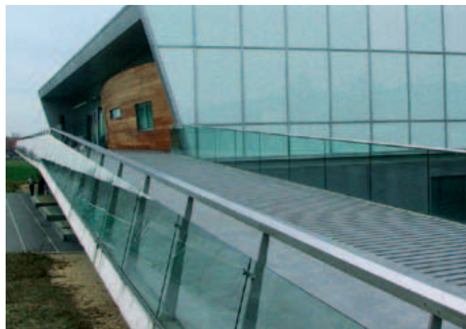
Accès à un bâtiment: garde-corps vitré avec main courante en acier chromé, hauteur 100 cm
