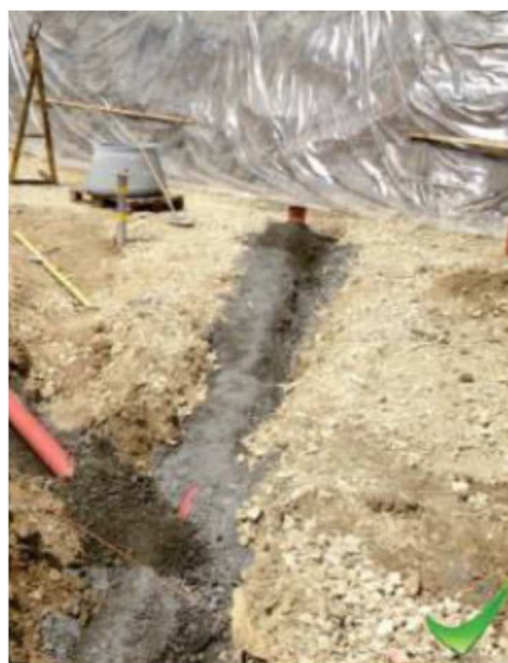
Canalisation en cours de bétonnage
