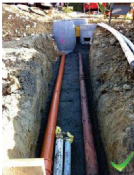
Canalisations AVEC assise bétonné
