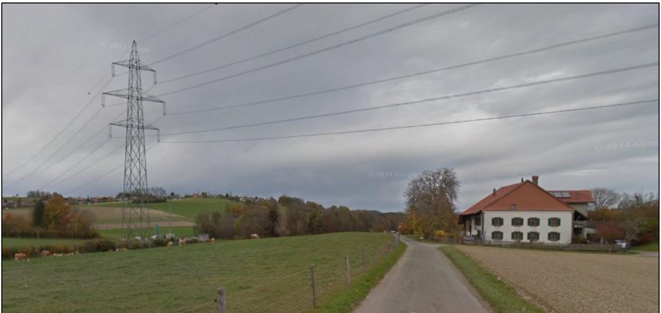
Pylône d'Essertes qui se verra équipé d'une antenne 5G
