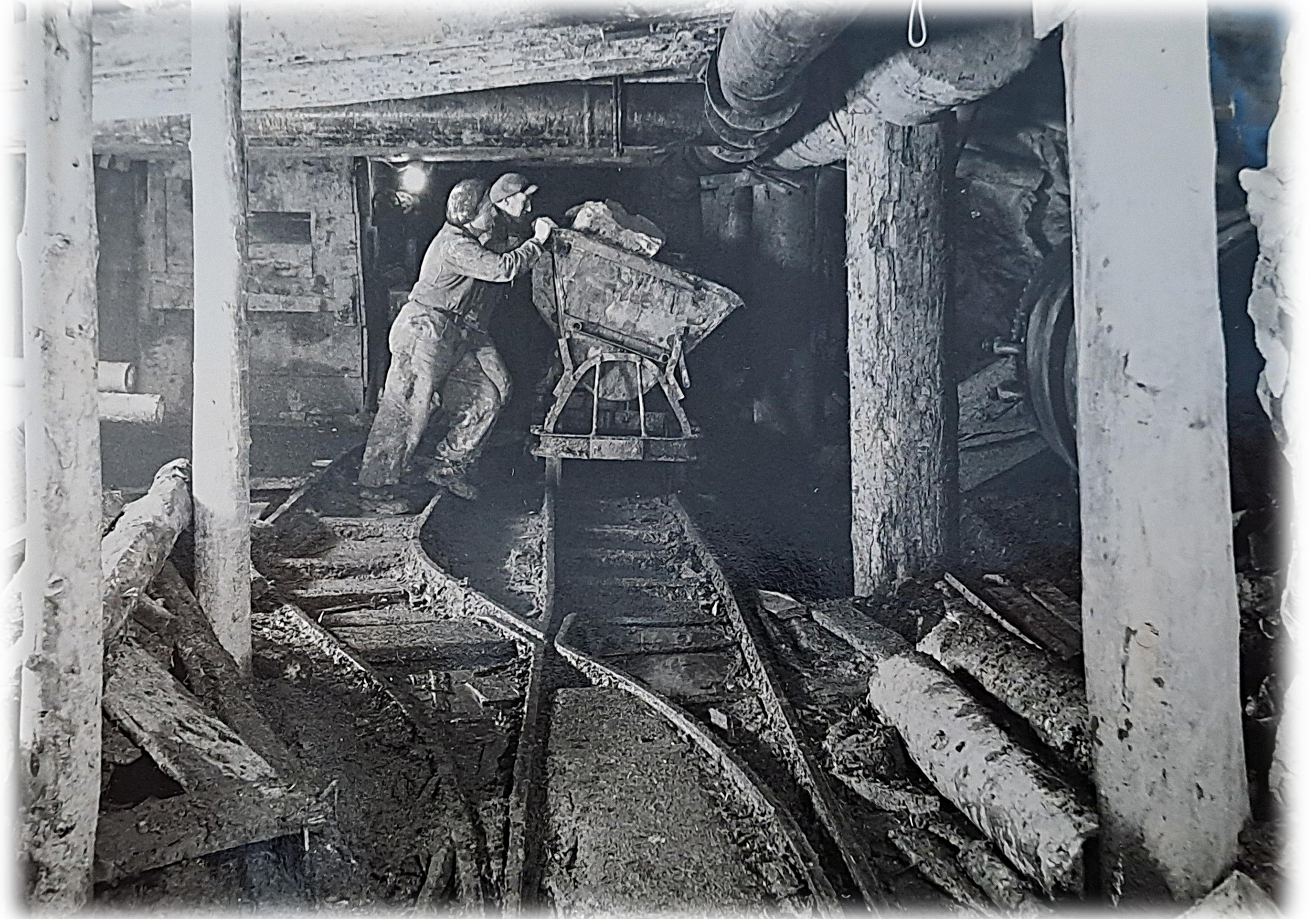
Mineurs déversant des déblais sur un tapis roulant en bas d'une descenderie en profondeur
