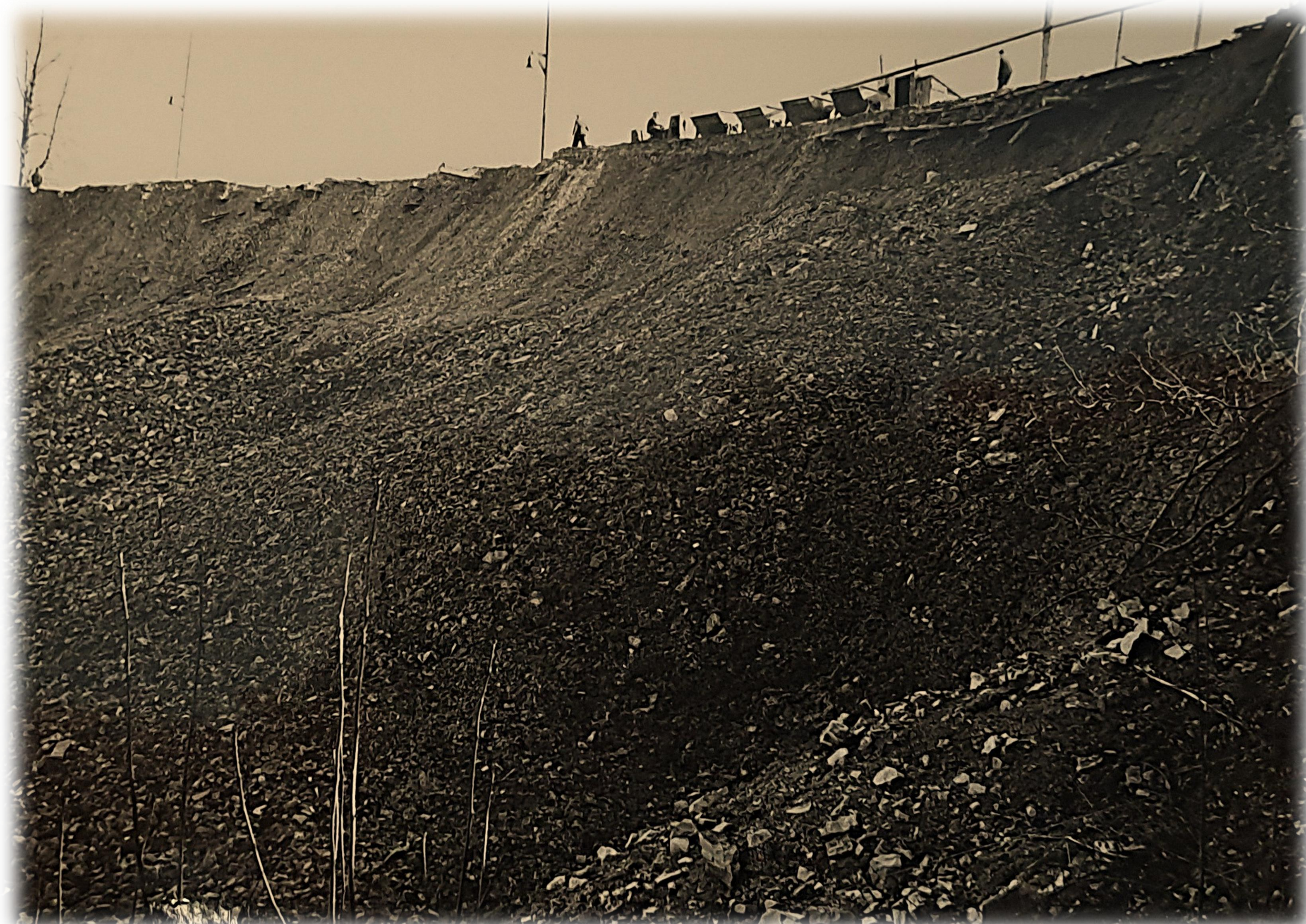
Wagonnets déversant les déblais dans le ravin du Flon, années 40
