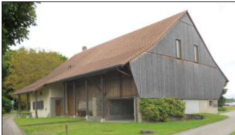
Exemple de ferme à Palézieux intégrée au dossier qui sera déposé au Canton
