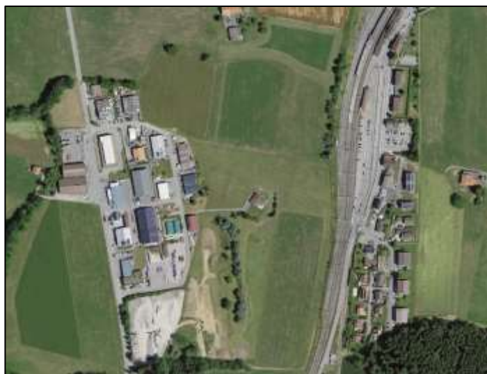
Exemple de la zone industrielle de Palézieux et de sa proximité avec la gare
