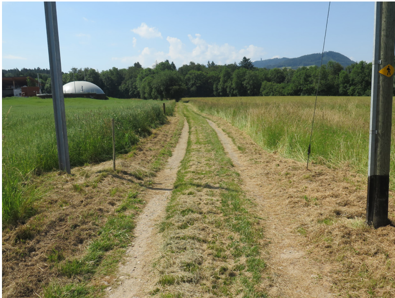
4. Palézieux-Village / La Condémine (peu au sud du virage de la route d'Ecoteaux): vue de la dévestiture agricole locale, tronçon d'autant plus remarquable qu'il s'agit du seul tracé routier encore en usage de l'antique voie.
