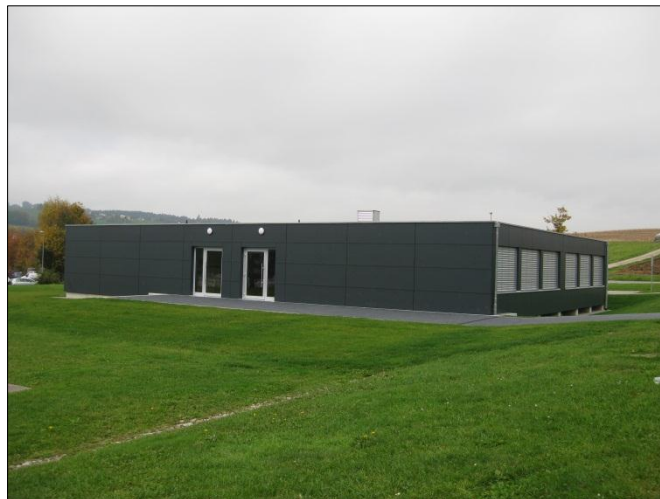
Oron-la-Ville – Pavillon scolaire
