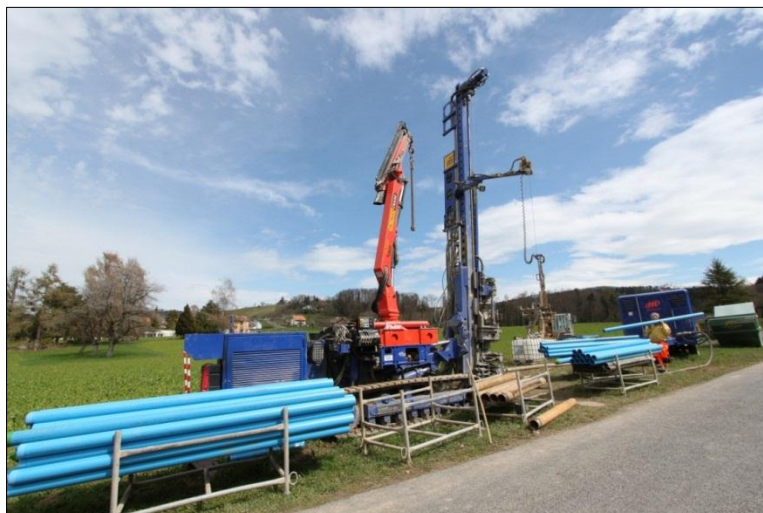
Travaux de forages à Ecoteaux, printemps 2012
