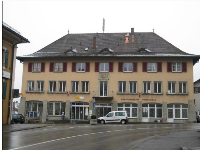
Oron-la-Ville – Bâtiment communal
