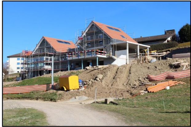
Châtillens - Villas en construction
