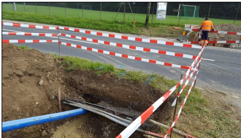
Pousse tube sous la route cantonale
