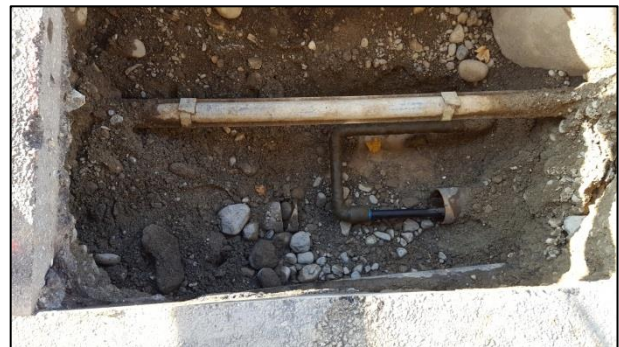
Raccordement de l'ancienne Poste
