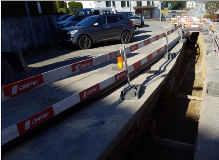
Fouille devant le restaurant Pad-Thai
