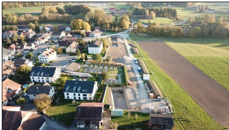
Chantier des Retraites populaires, Palézieux
