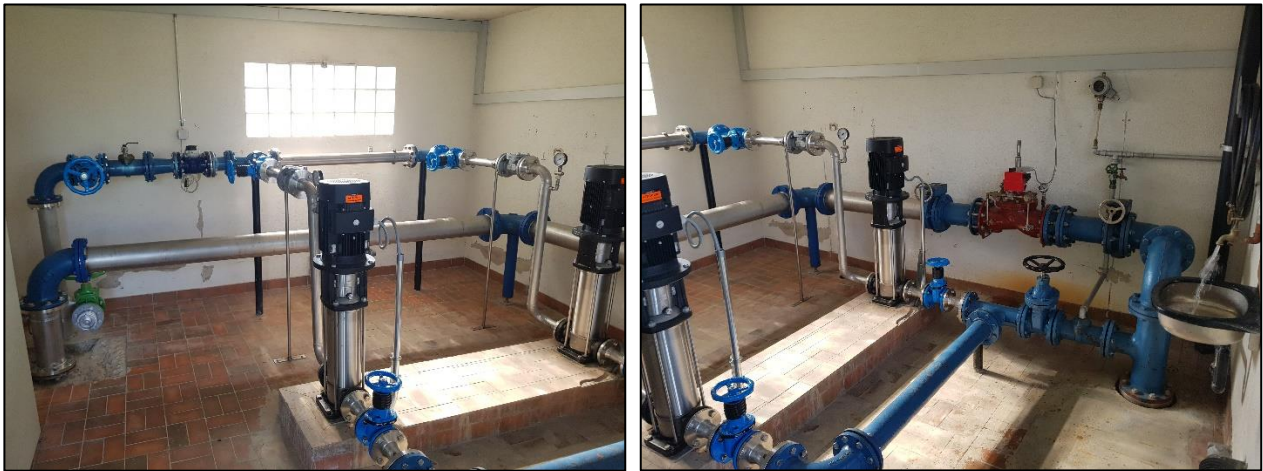
Station de Platta-Pierre avant travaux
