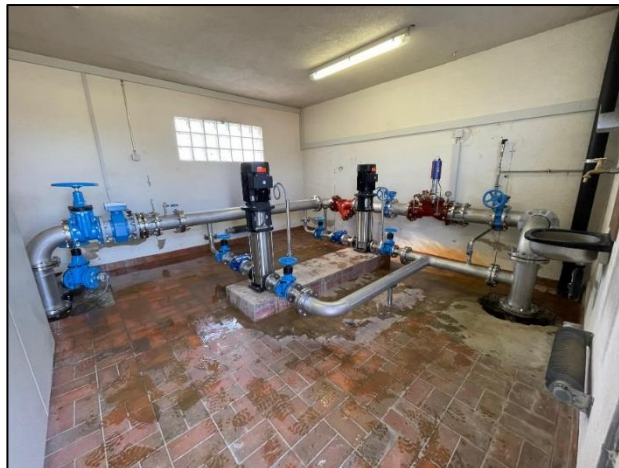
Station de Platta-Pierre après travaux
