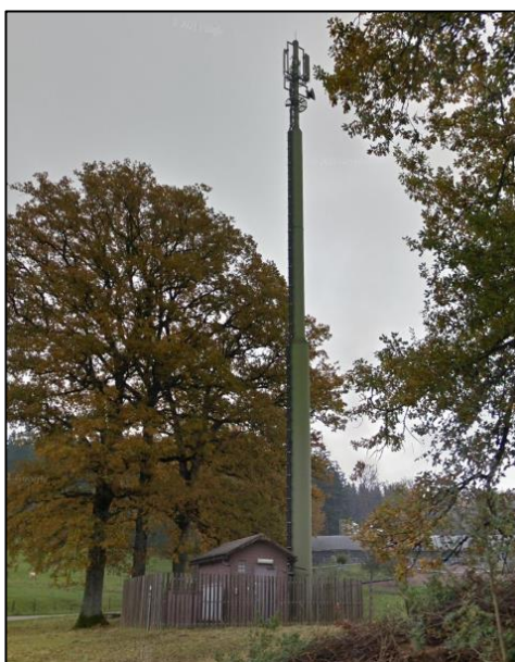
Antenne existante à Palézieux, faisant l'objet d'un recours à la CDAP pour son adaptation à la technologie 5G (Google Map)
