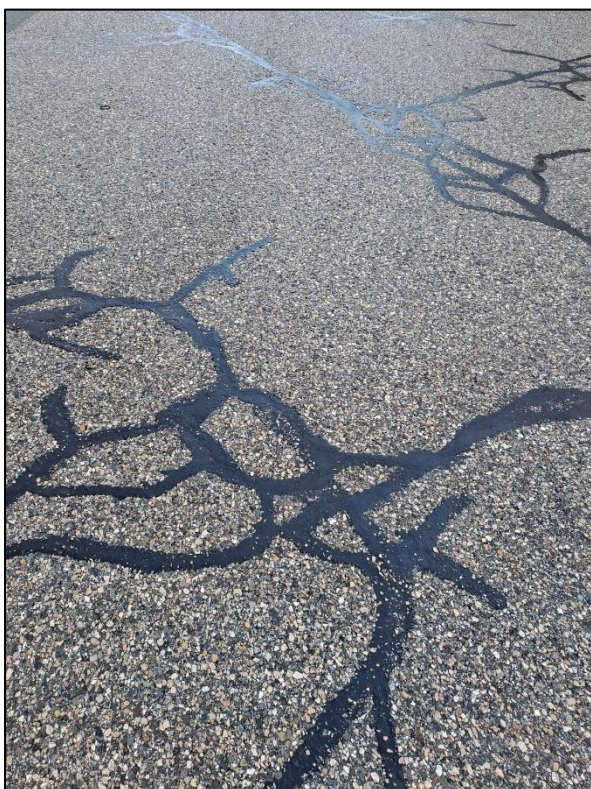
Pontage des fissures
