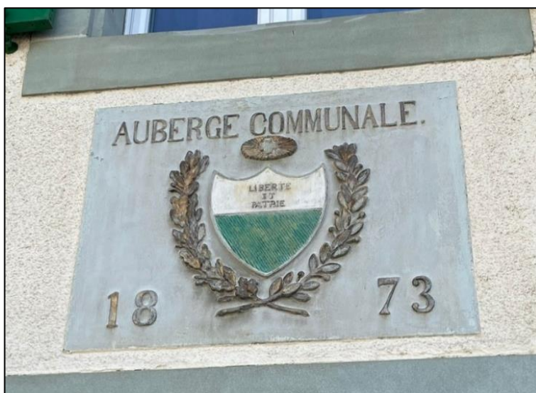
En façade, l'inscription atteste de la date de rénovation du bâtiment après l'incendie du 8 août 1872 qui détruisit tout le quartier
