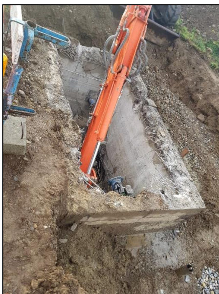
Démolition de la chambre de Pradin, Oron-la-Ville
