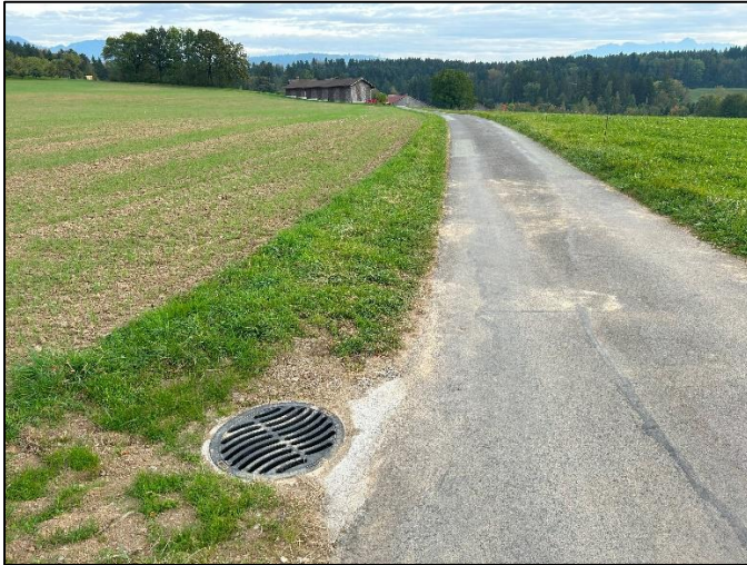
Nouvelle chambre après travaux
