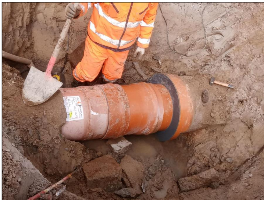
Réparation d'une conduite EC
